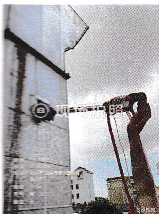
FQ-31253排气筒后
