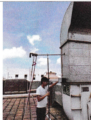
FQ-31251 排气筒后
